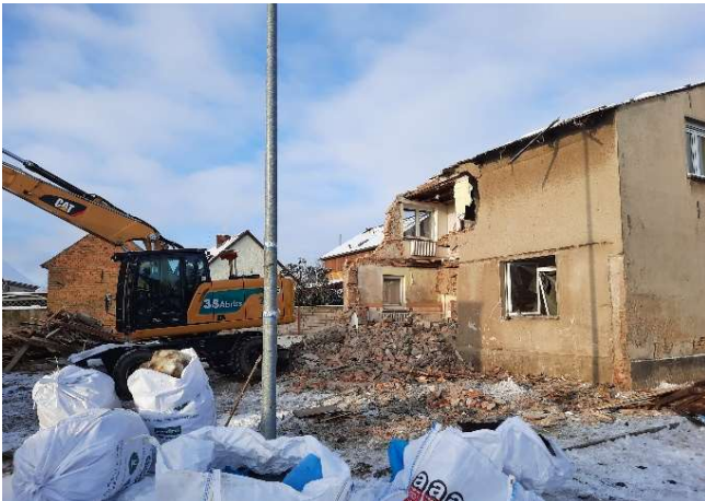
Abriss des leerstehenden Wohnhauses
