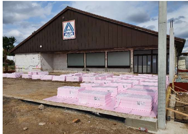
Hier entsteht das Fundament für die ALDI-Erweiterung
