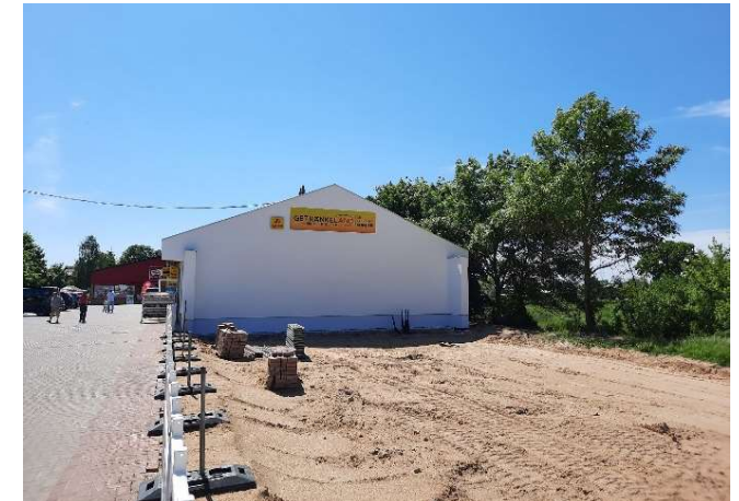
Neue Fassade am Gebäude II
