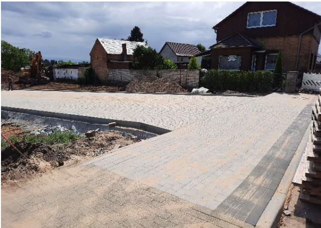
Die etwas nach Westen verlegte Zufahrt ist bereits fertig
