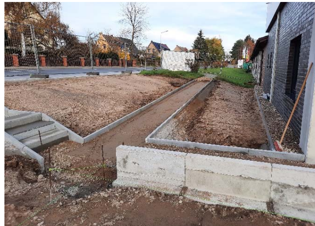
An den Außenanlagen gibt es noch einiges zu tun ...
